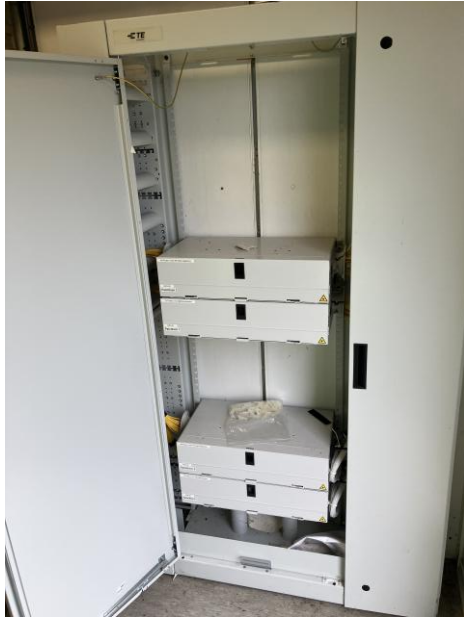
Abbildung 9: Vorhandener FIST-Schrank KH Wahlstedt
