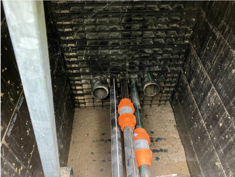
Abbildung 5: ankommende Leerrohre 2xDN110 und 3xDN50 aus südl. Richtung im KS bei km 8,0
