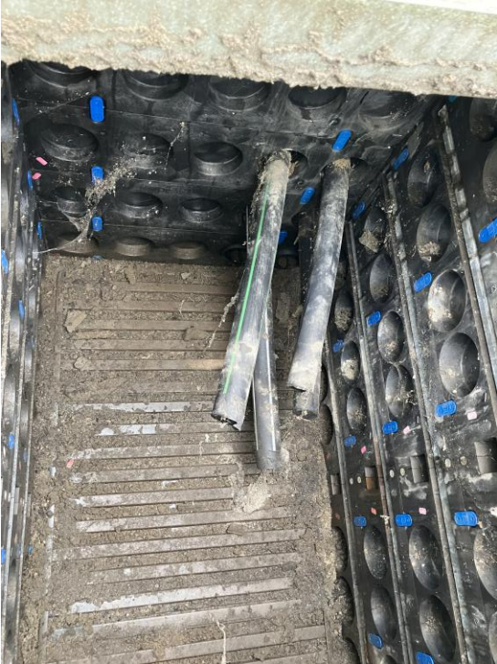
Abbildung 3: endende Leerrohre 4xDN50 von Süden im KS bei km 20,1
