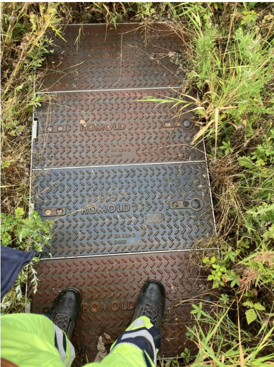
Abbildung 4: KS-Deckel bei km 8,0
