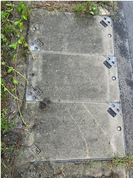
Abbildung 2: KS-Deckel bei km 20,1
